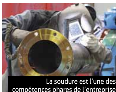
Fabrication d'un tuyau pour une chaudière industrielle
